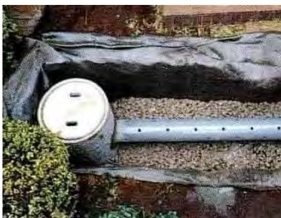
＜敷地内の雨水浸透トレンチ＞
