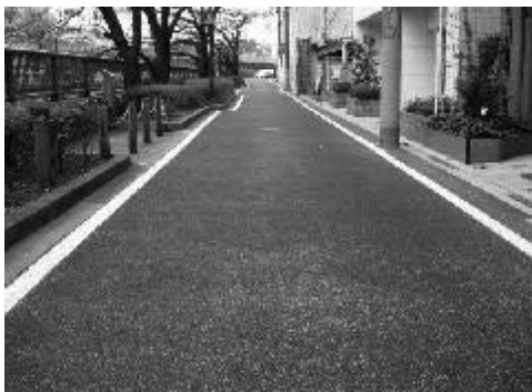
保水性舗装の施工例：目黒川沿い
