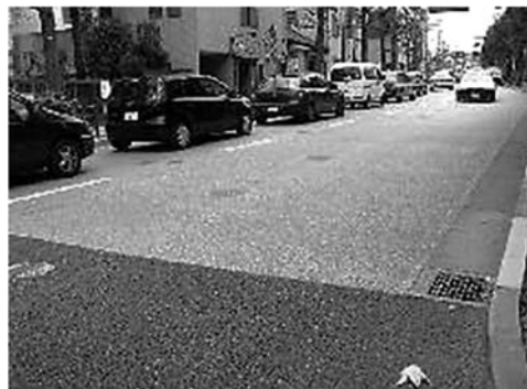
遮熱性舗装の施工例：駒沢通り(都施工)
