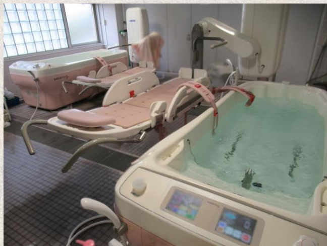
特別養護老人ホーム東が丘 機械浴槽
