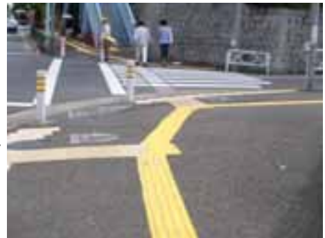
視覚障害者誘導用ブロックとエスコートゾーン（横断歩道内）の事例（駒沢通り／目黒区）
