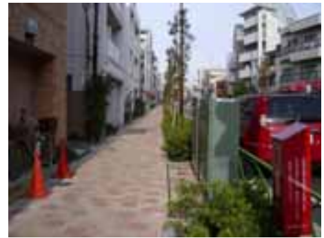
歩道整備と電線類の地中化の事例 (都市計画道路補助30号/目黒区)
