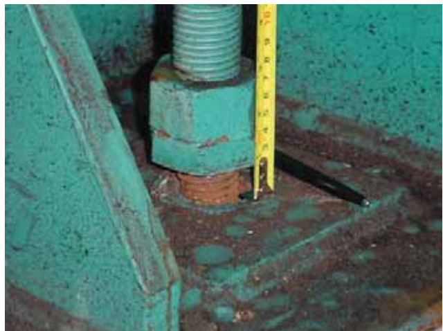
写真一 1 0 筋違を受ける露出型柱脚のアンカーボルト降伏 (ペルー南部 (Atico) 地震、東大生研大井研撮影)
