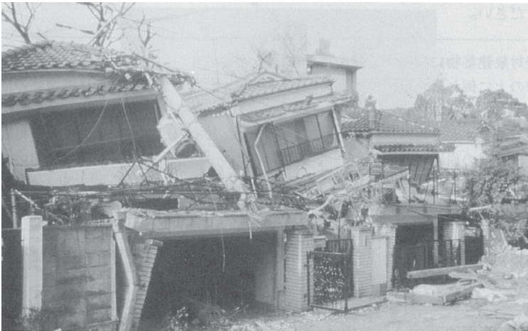
地下車庫併用住宅の層崩壊
