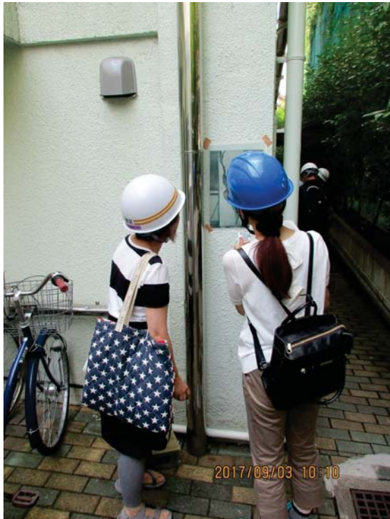
柱の被害写真から損傷度を判定
