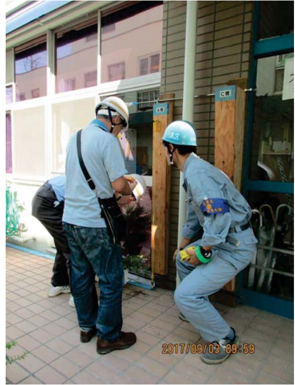
下げ振りによる傾斜角の測定演習
