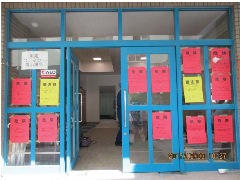
判定ステッカーの記入・表示状況
