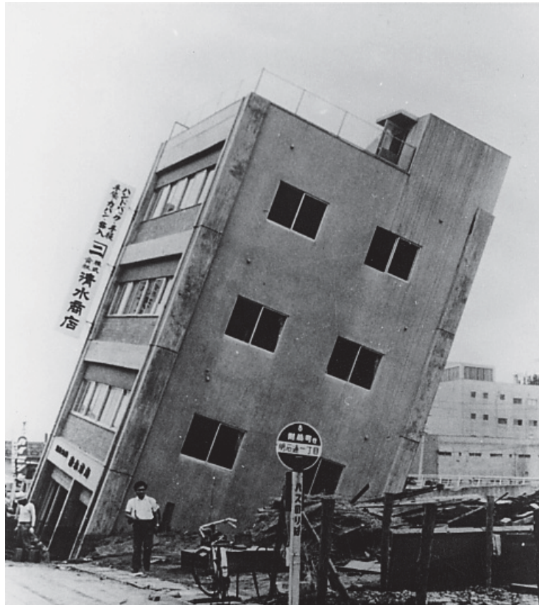
図-6 建物の全体傾斜が2度以上の被害例 (1964年・新潟地震／芝浦工大・岡田研究室)
