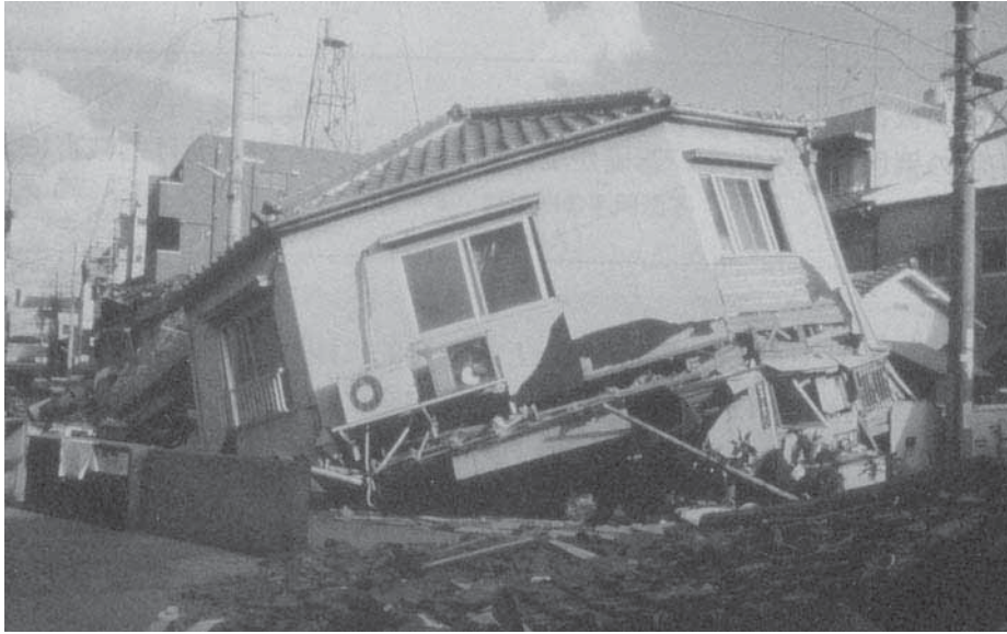
写真－２ 一見して危険と判断される
