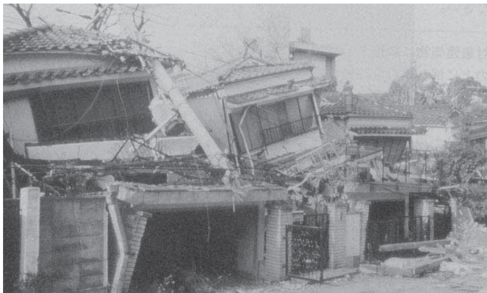
写真－1 一見して危険と判断される
