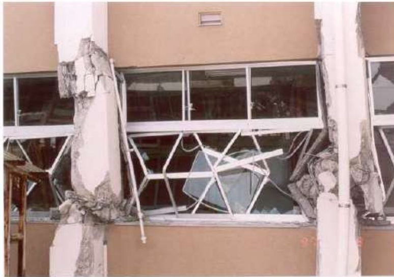
(c) 柱頭および柱脚が曲げせん断破壊し高さ方向に変形が生じている。 (1997 年・鹿児島県北西部地震)
