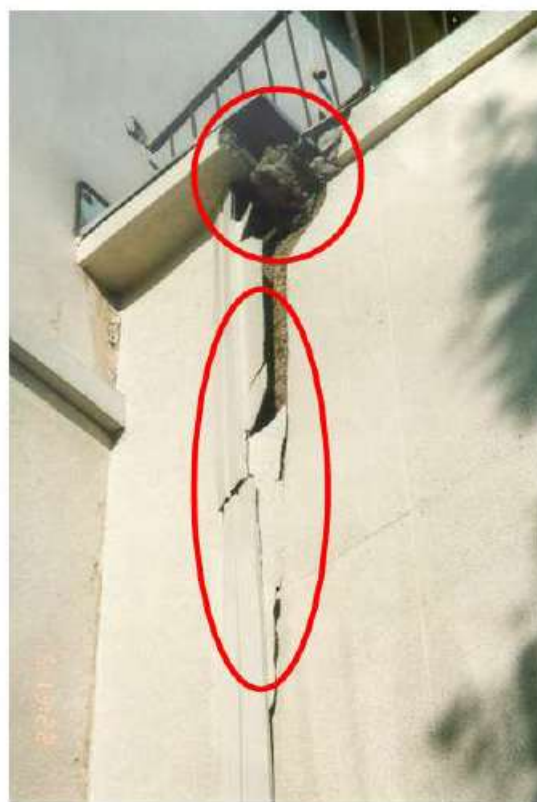
(b) エキスパンション・ジョイント部でのコンクリート、外壁の落下危険性有り (1994 年・三陸はるか沖地震)
