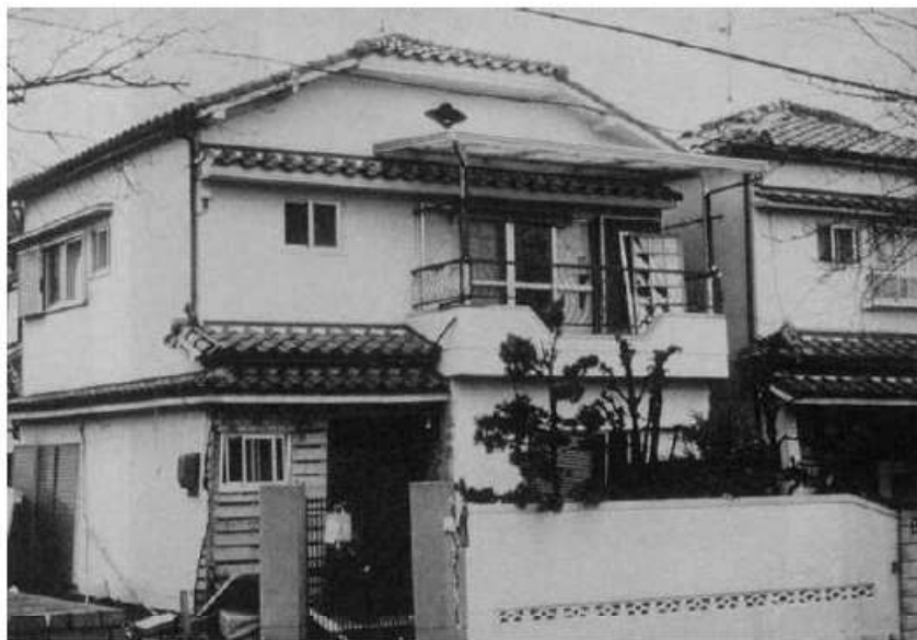
写真-9 壁の被害（外壁、ランクA）
