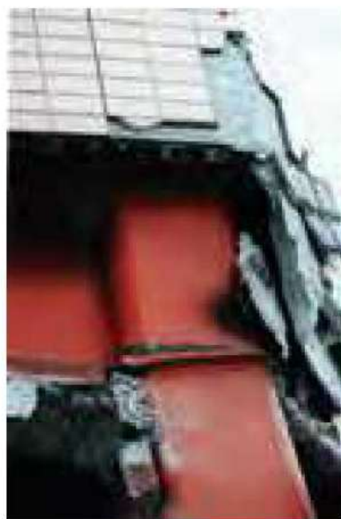
写真一7 柱とダイアフラム溶接部の破断 (兵庫県南部地震)
