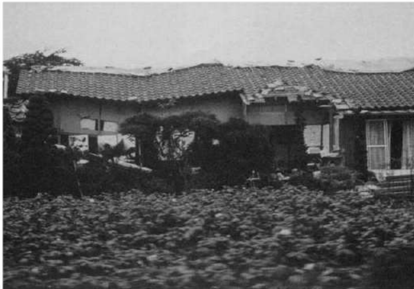
写真-4 建築物の不同沈下（ランクB）
