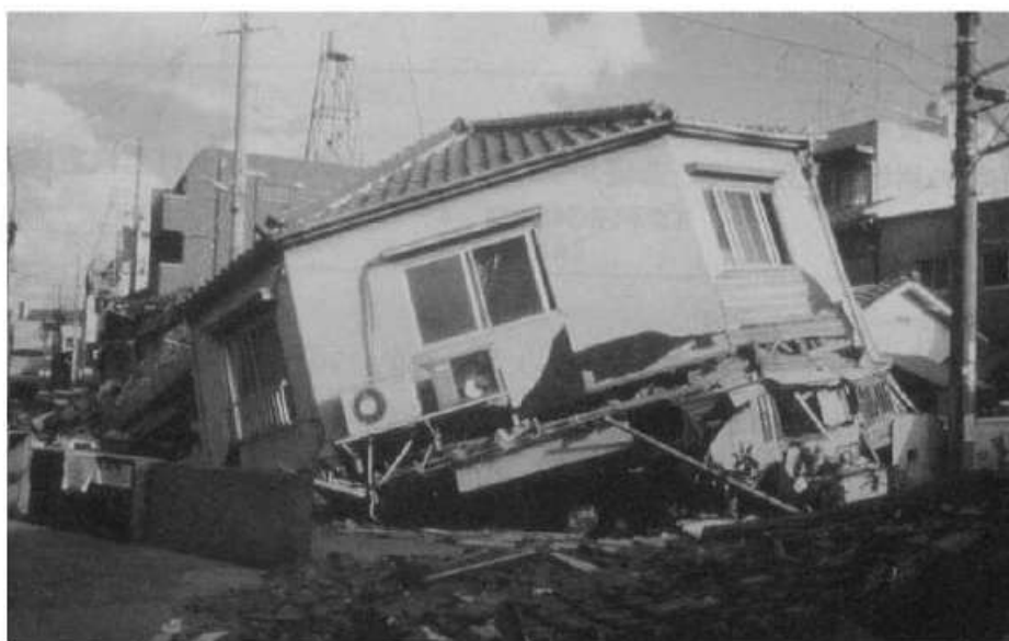
写真－２ 一見して危険と判断される
