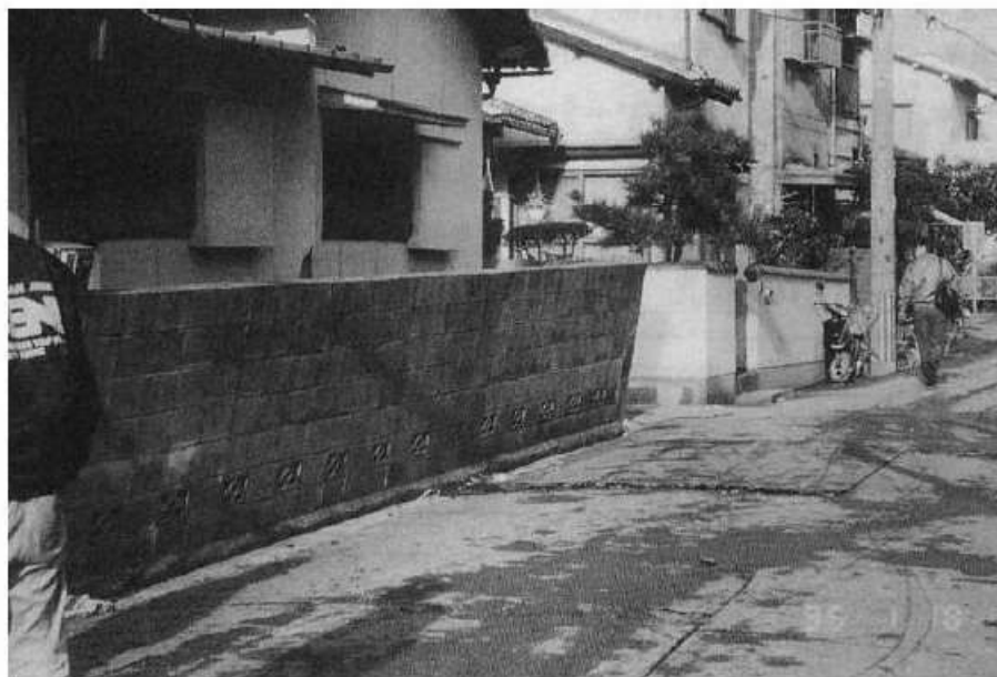
写真-19 転倒危険物（ブロック塀）（ランクC）
