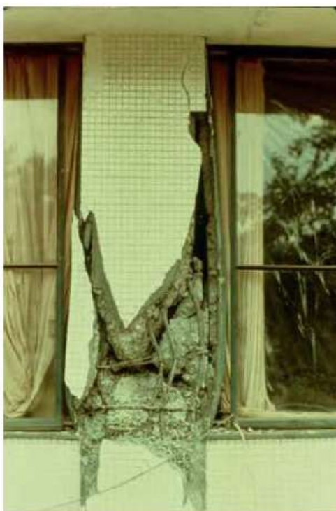
(b) 鉄筋が曲がり、内部のコンクリートも崩れ落ち、一見して柱の高さ方向に変形が生じていることがわかる。(1978年・宮城県沖地震)
