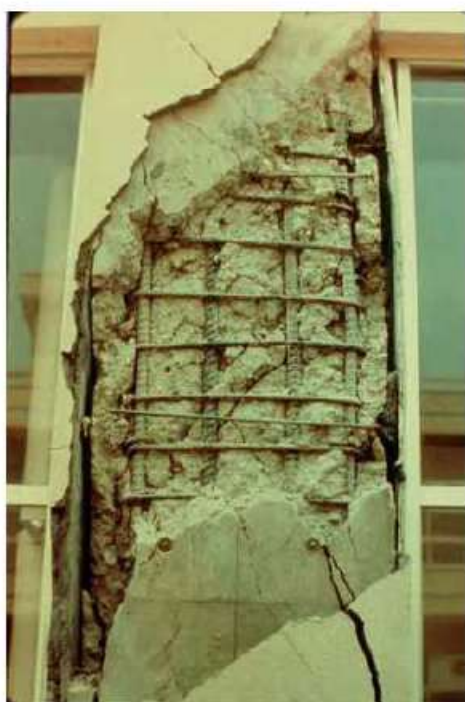
(b) 2mm を超えるひび割れが生じ、コンクリートが剥落して鉄筋が見えるが座屈等の変形は見られない。(1978 年・宮城県沖地震)
