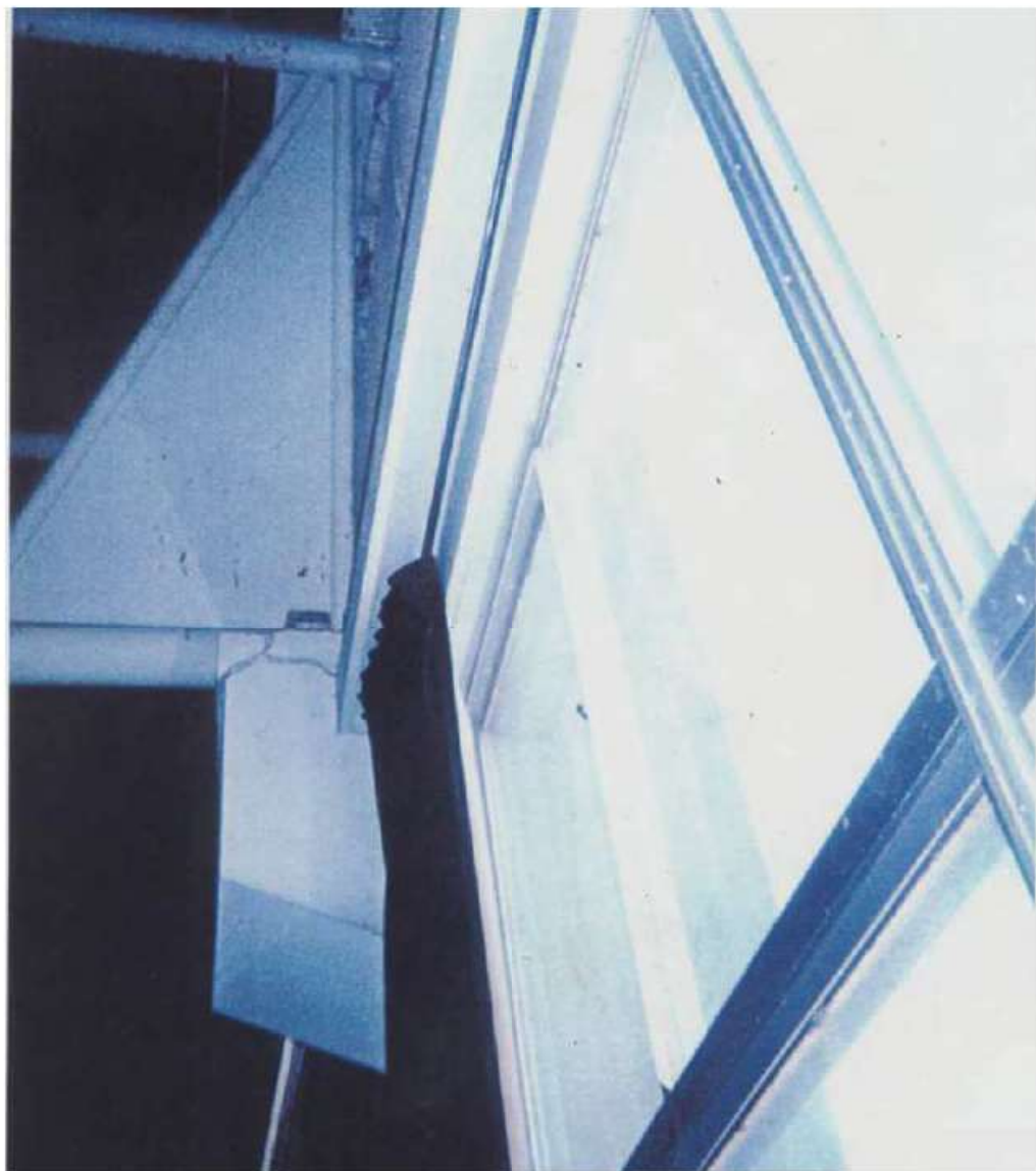
写真－１２ 鉄骨屋根定着部の損傷によるコンクリート片の落下危険性（兵庫県南部地震、東大生研大井研提供）
