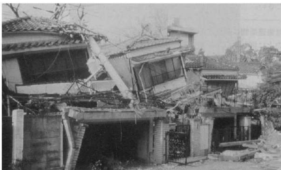
写真－1 一見して危険と判断される
