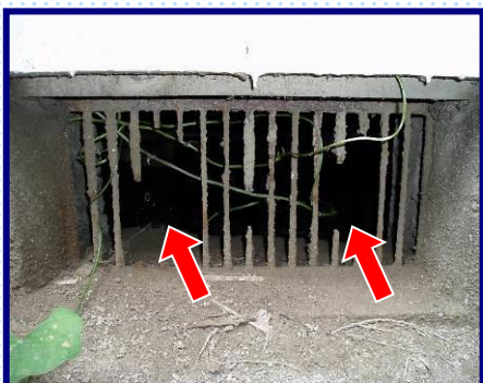
床下の通風口
