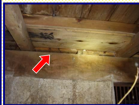
出窓や縁側の下部(土台と床板の間)
