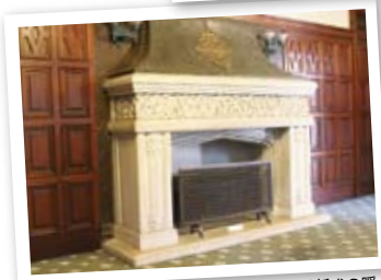
▲全館スチーム暖房完備：各部屋に当時最新式の暖房設備があった。これは煙突のない暖房で、地下で石炭とボイラーを使用して発生させた熱を全館へ回していたそうです。
