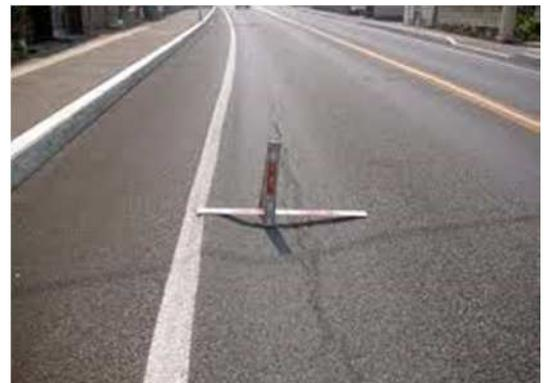
ひび割れ率 : ひび割れは、舗装表面に亀裂が入る現象で、線状、亀甲状及びその両方の形態がある。本計画におけるひび割れ率は、調査区間20mの面積に占めるひび割れている舗装の割合
