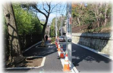
目切坂（工事中）
