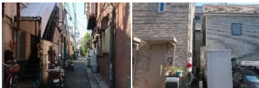
地区全体の延焼の危険性が高い建詰まりが進んだ市街地（都内事例）
