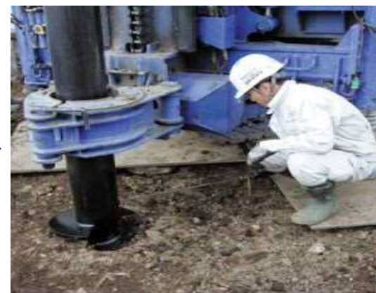
鋼管杭回転埋設状況
