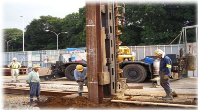
重機による山留材挿入
