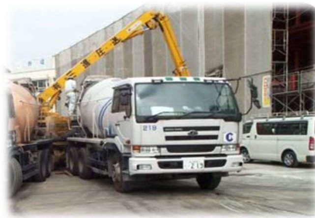
コンクリート打設
