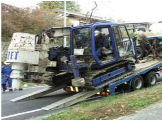
杭打ち機搬入
