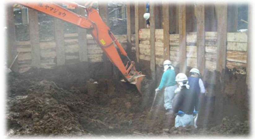
重機による掘削
