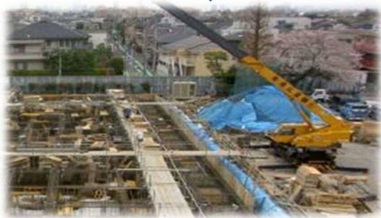
躯体配筋・型枠建て込み
