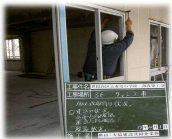
鋼製建具工事
