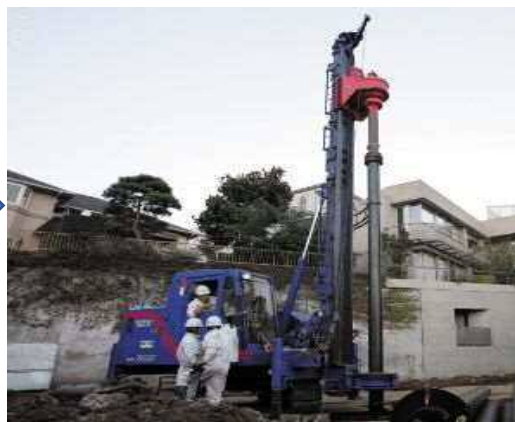
鋼管杭施工状況
