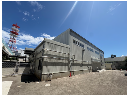
仮設体育館の外観
