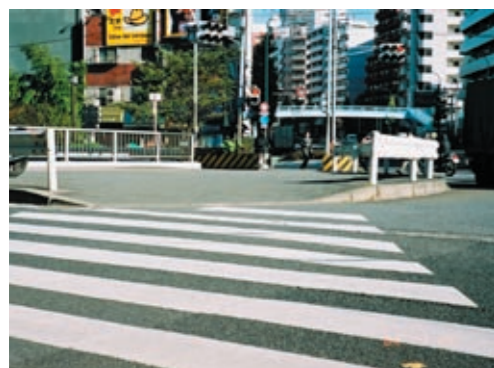
13) 中目黒立体交差横断歩道部 ・交通島部分は段差が無くなるようすりつけられているが、勾配がきつい。
