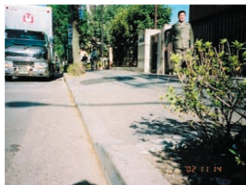
15) 山手通り共済病院に向かう歩道 ・歩道の横断勾配がきつい。
