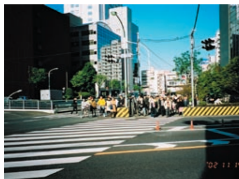
14) 中目黒立体交差横断歩道部 ・交通島部分は段差が無くなるようすりつけられているが、勾配がきつい。
