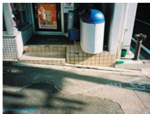
16) 山手通り共済病院に向かう歩道 ・歩道の縦断勾配がきつい。 ・歩道と車道の高さを同じにできないか。歩道の波打ち、傾斜の改善が必要。
