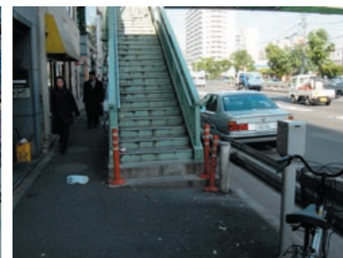
18) 山手通りやわた歩道橋 ・階段により歩道の有効幅員が阻害されている。
