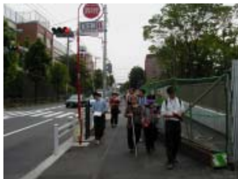
工事中の総合庁舎前
