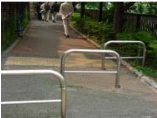
車いすが通りにくい柵
