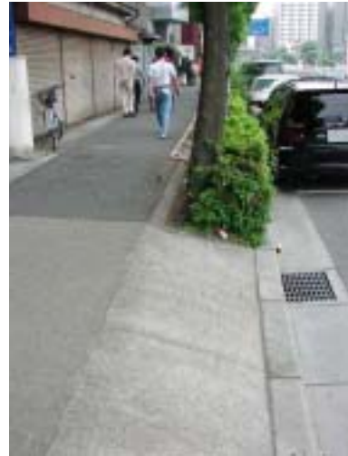
歩道から車道への段差
