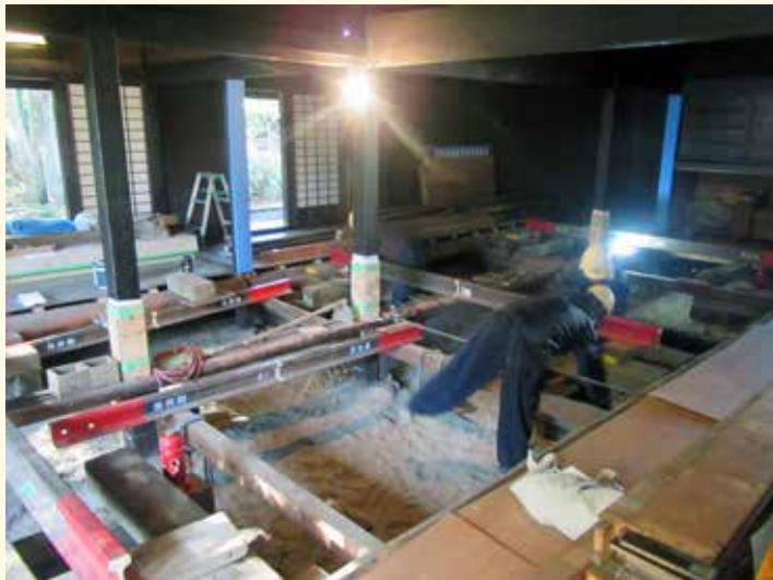
写真5 基礎改修工事の様子(平成26年撮影)
