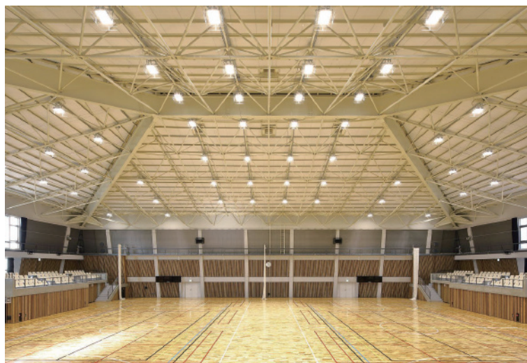
大規模改修工事を終えた中央体育館競技場
