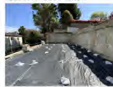
⑦ 敷地中段全景
