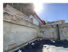
⑥ 敷地下段の周囲境界部分
