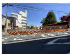
② 道路接道部分全景
