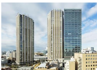
市街地再開発事業により 誕生した目黒駅前の高層ビル
