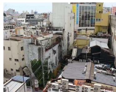
老朽化した建物群
