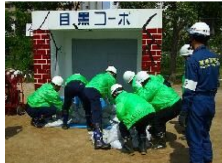
区民による積み土のう工法
