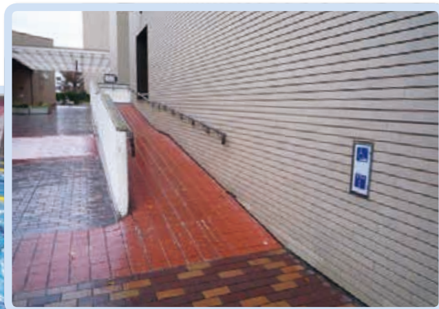
（区民センター内のスロープ）
