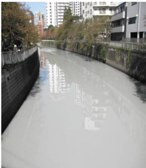
写真 2 白濁化の状況 (H27年10月)
