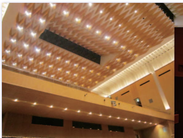
大ホール 天井
