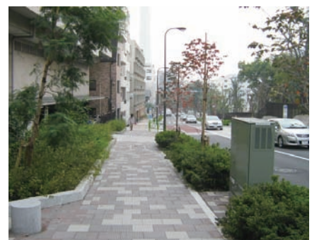
電線類の地中化
