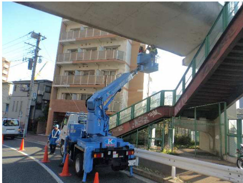
写真-2 高所作業車による点検
