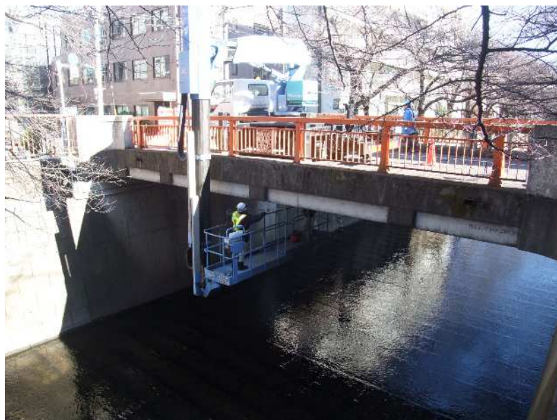
写真-1 平成27年度定期点検の様子
