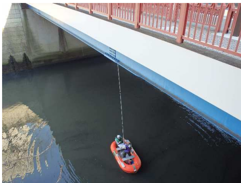
写真-3 ゴムボートによる点検
