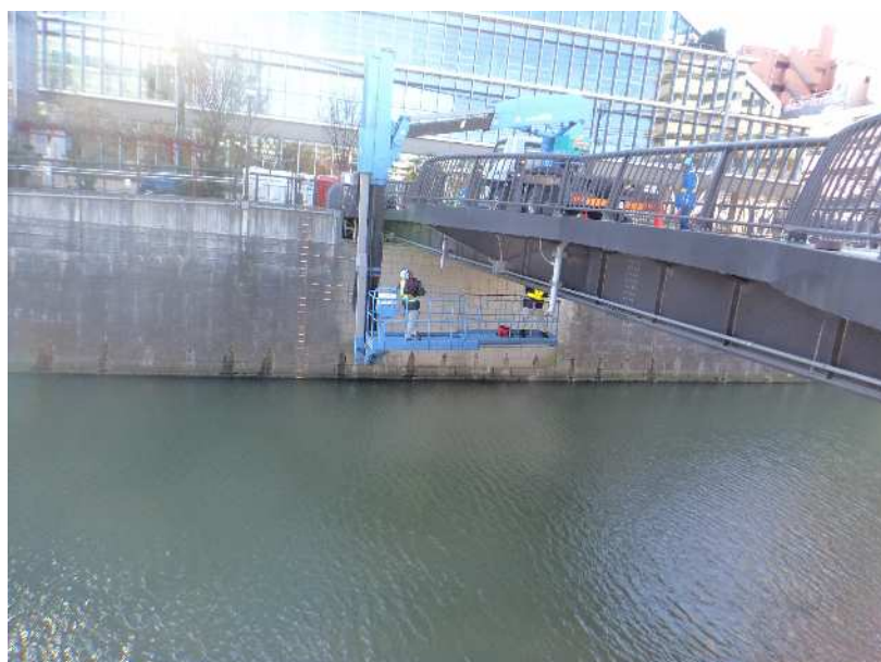
写真-4 橋梁点検車による点検
