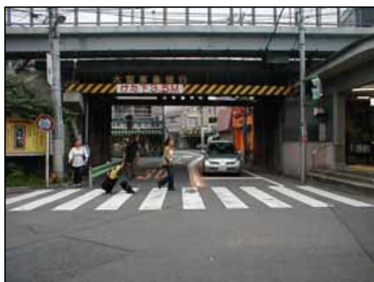
桁下高さが低い駅前の架道橋
