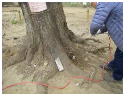
図 4-4 ファインノズルによる圧縮空気をを用いた細縦穴掘削作業中
