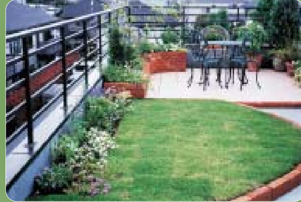
屋上で優雅な時間を過ごしています(南の施工例)
