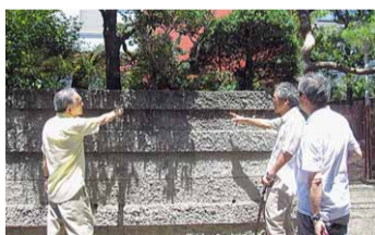
▲ブロック塀の点検 (南三丁目東町会)
