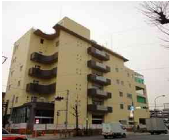
工事が進む目黒本町福祉工房
