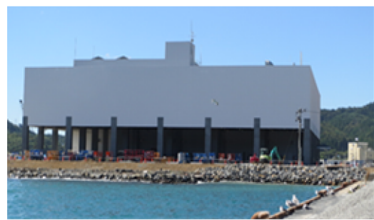
漁協の冷凍冷蔵施設が建設
