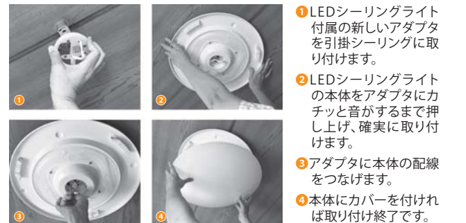
図5 LEDシーリングライトの取り付け方
